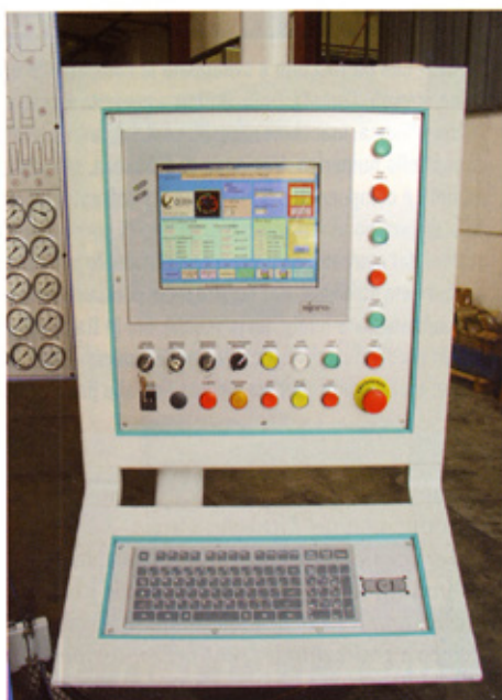
Fig. 1 Il monitor con il CN della pressa.
